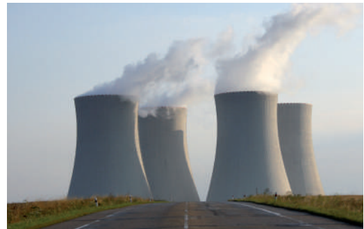
Transformirana energija u elektranama
