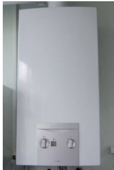
Kondenzacijski plinski kotao (bojler)
