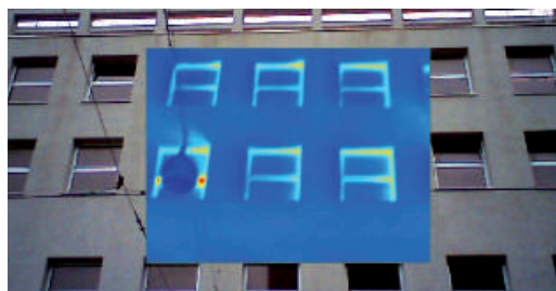
Toplinski zadovoljavajuće izolirana zgrada
